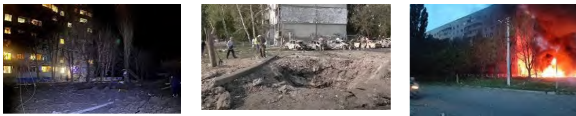
Рис. 4.11. Наслідки обстрілу по вулиці Харківська в місті Чугуїв [179]
