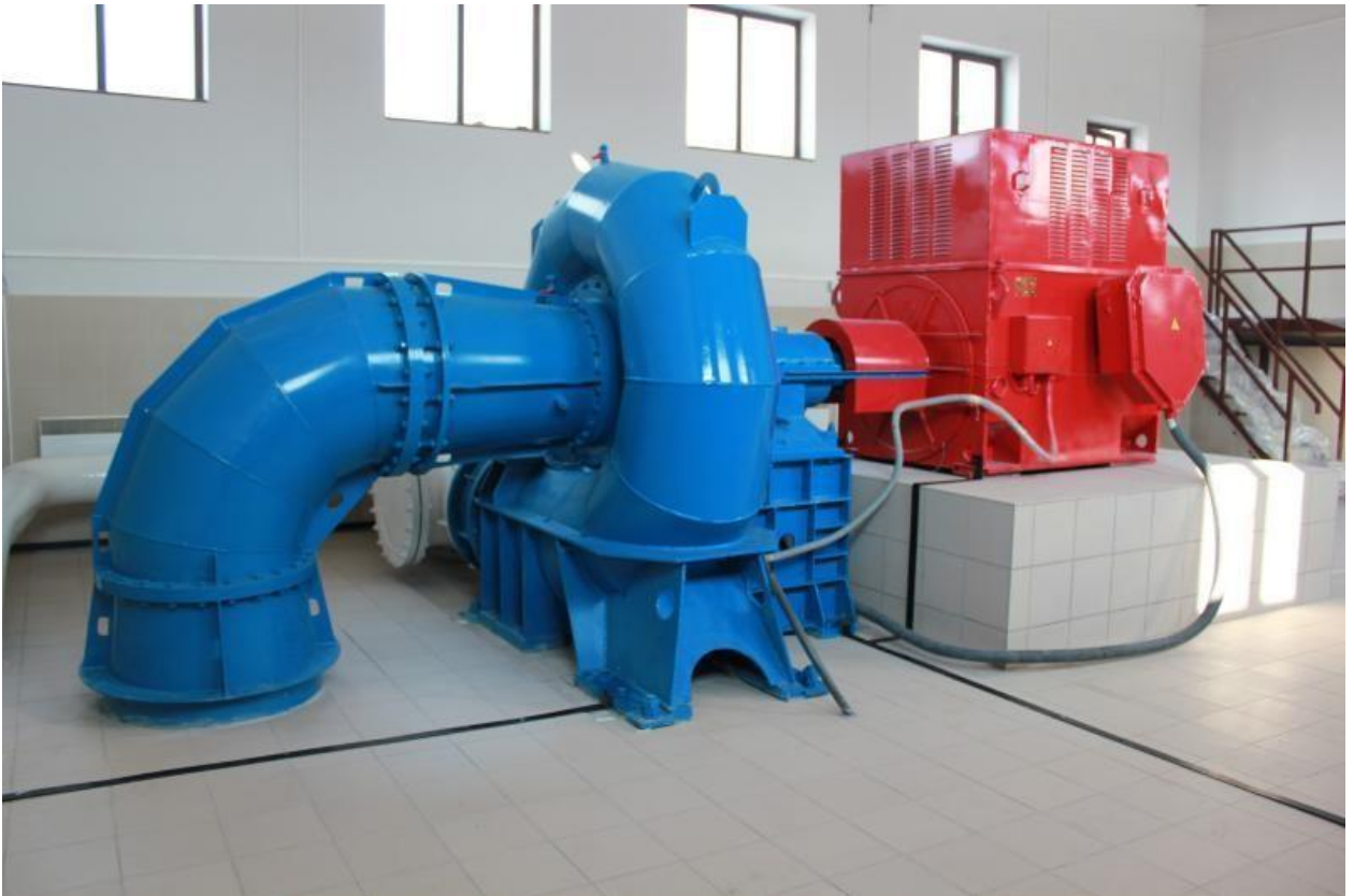
Рисунок 3.1 – МікроГЕС з генератором 100 кВт
