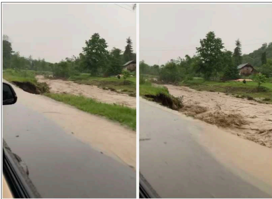
Рисунок 2.13 – Еродована дорога через розлив річки Східничанка, Львівська область. Фото зняті із інтервалом 30 хвилин (2023 рік) (джерело: фото автора).
