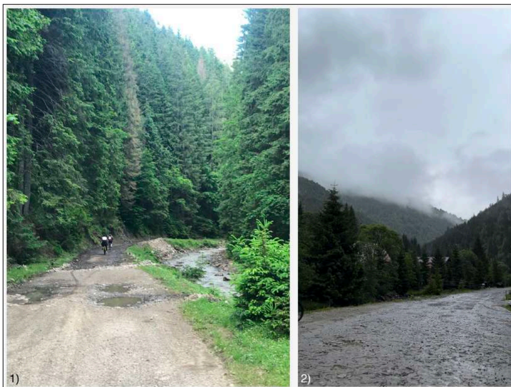
Рисунок 2.12 – (1) Еродована дорога між селами через паводки на річці та (2) розмокання дороги під час опадів у Міжгірському районі Закарпатської області (2024 рік) (джерело: фото автора)
