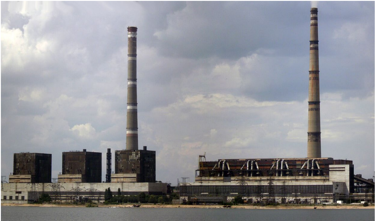
Рис. Г.1. Загальний вид Запорізької теплової електростанції
