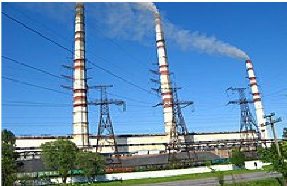
Рис. Г.3 Загальний вид Бурштинської теплоелектростанції
